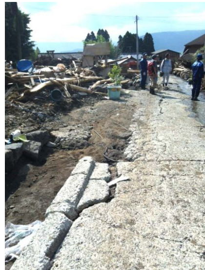
崩壊した道路
