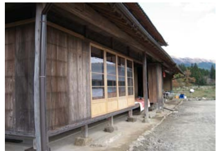
南側からの外観
