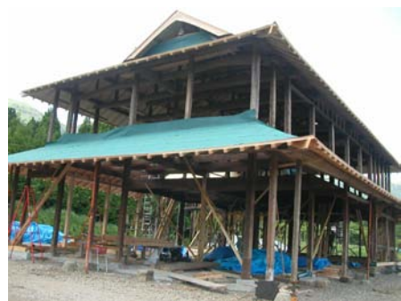
古民家移築中
