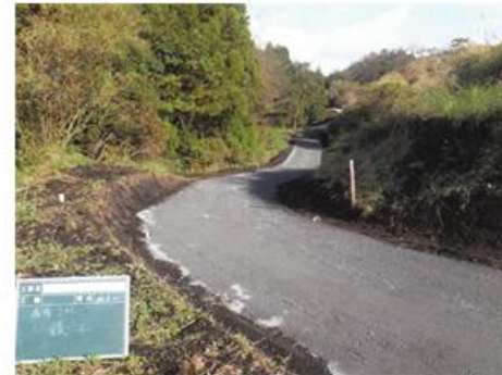
鉄鋼スラグ舗装（馬場豆札牧野）
